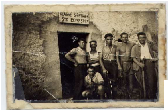
Maquis Barrage de l'Aigle : Juan Escoriza (à droite en chemise blanche)
